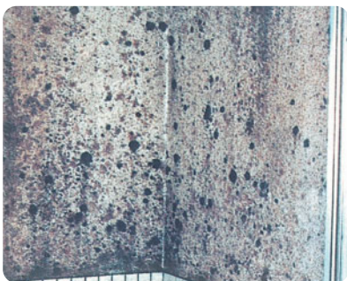
バイオタイト施工前
